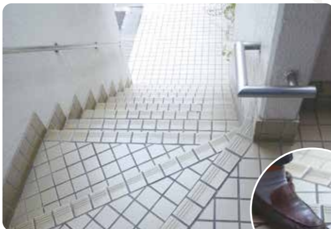
階段中央部分にクリアグリップを施工
